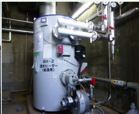
共用棟ボイラー (重油からガスに変更することで燃焼効率の向上、CO2削減)
