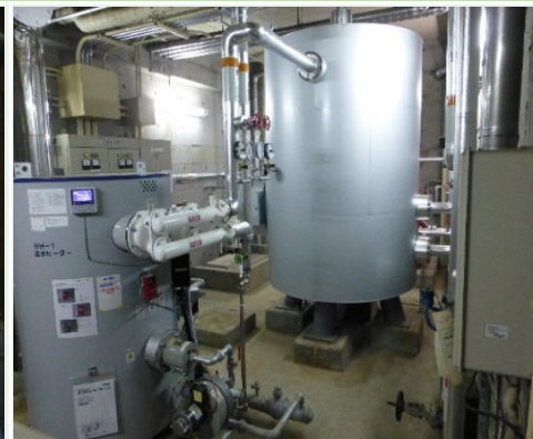
共用棟ボイラー (重油からガスに変更することで燃焼効率の向上、CO2削減)
